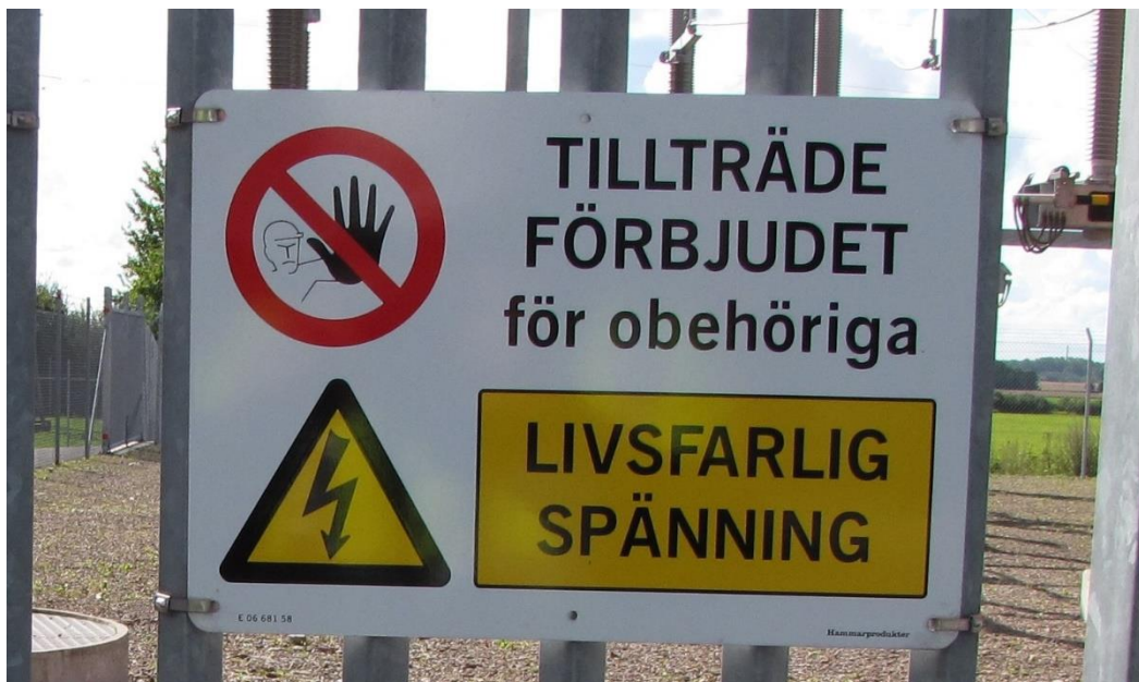
Bild 5 Skylt på grind eller dörr som utmärker driftrum
